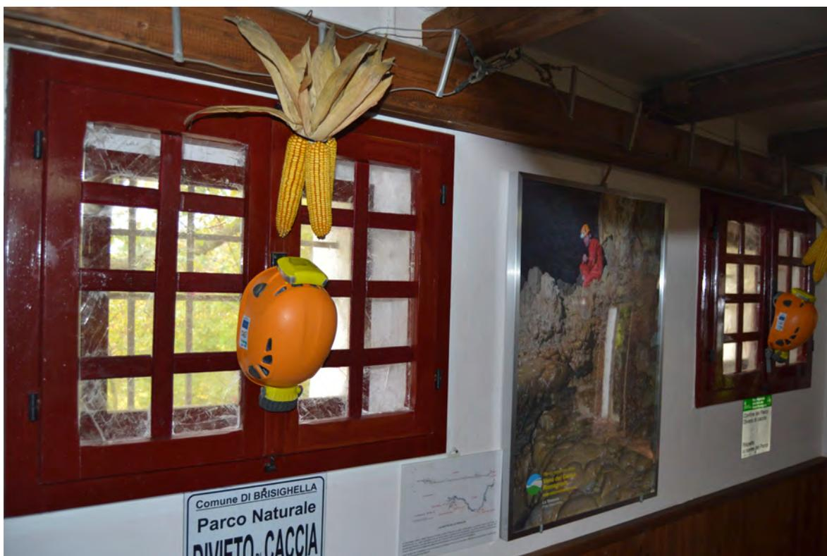
Fig. 2. Le finestre in *lapis specularis* posizionate all'interno del rifugio di Ca' Carnè, Brisighella (RA).
