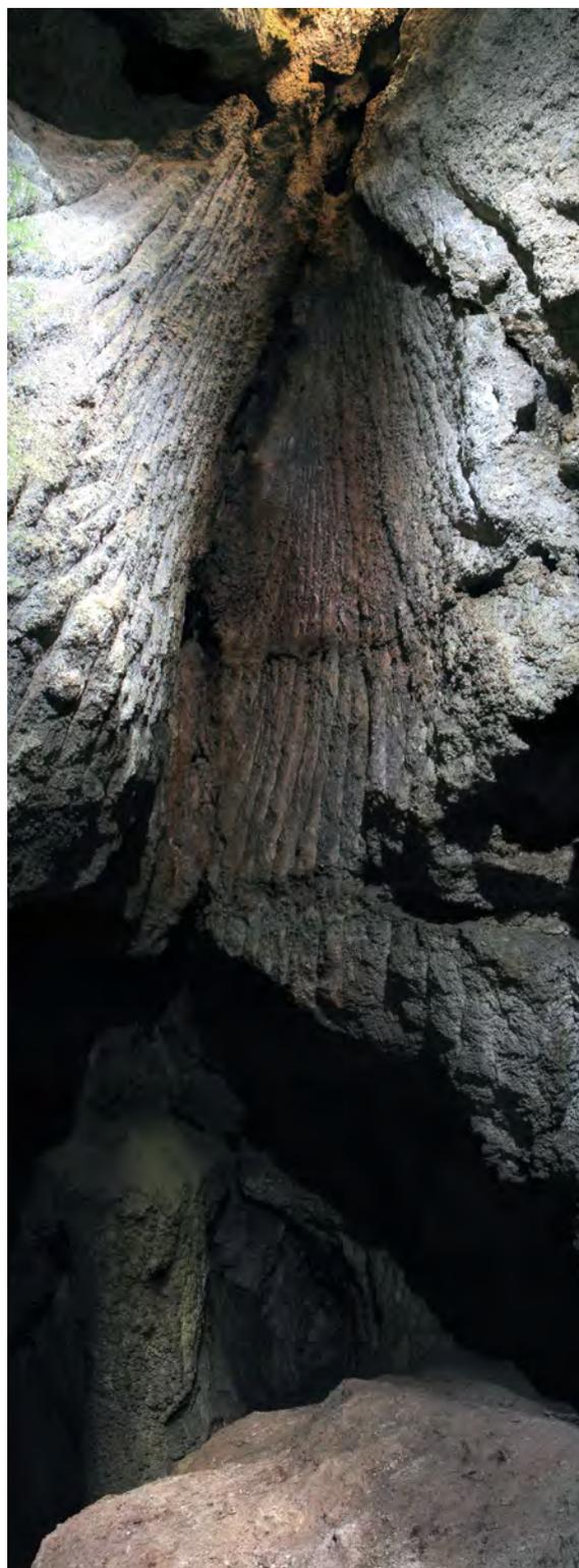
Fig. 2. Tracce di scalpellature regolari nei pressi dell'ingresso (foto P. Lucci).
