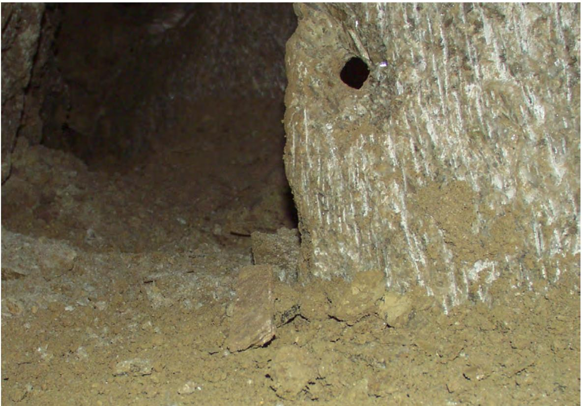
Fig. 12. Cava della Lucerna, foro per corda (foto S. Marabini).
